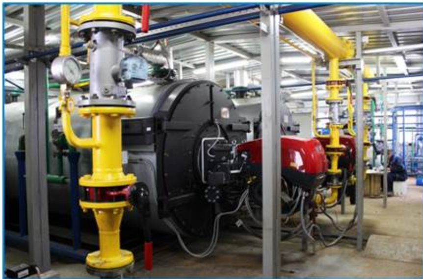
Насосные станции ДОНЭНЕРГО
