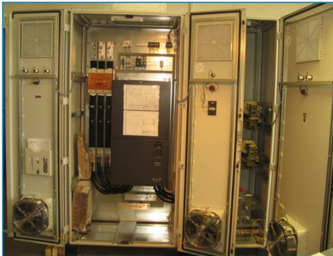
Шкаф управления насосной станцией с преобразователем частоты Delta CP2000 220 кВт
