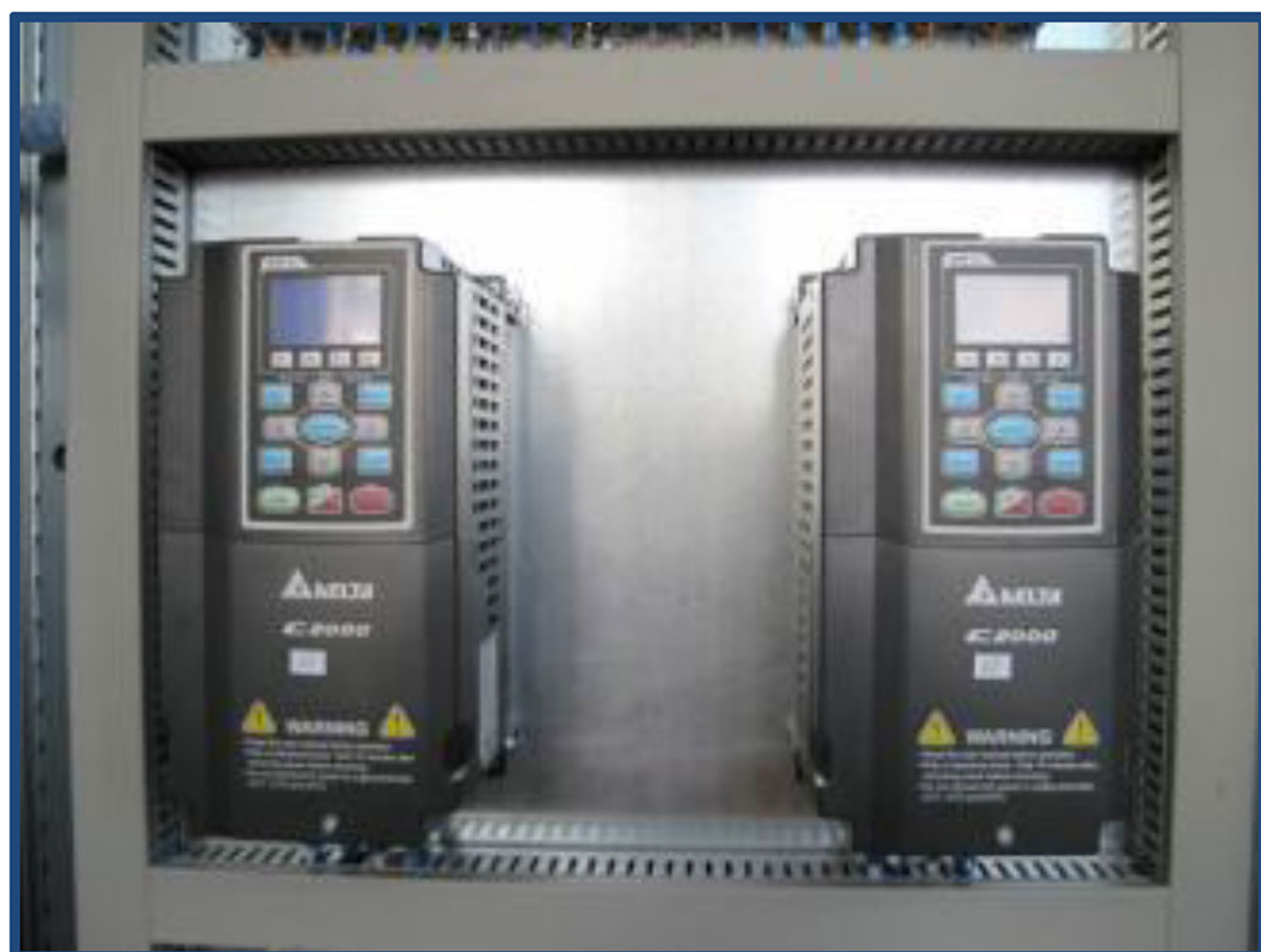
Преобразователи частоты DELTA CP2000 (3 шт.) управляют тремя насосами
