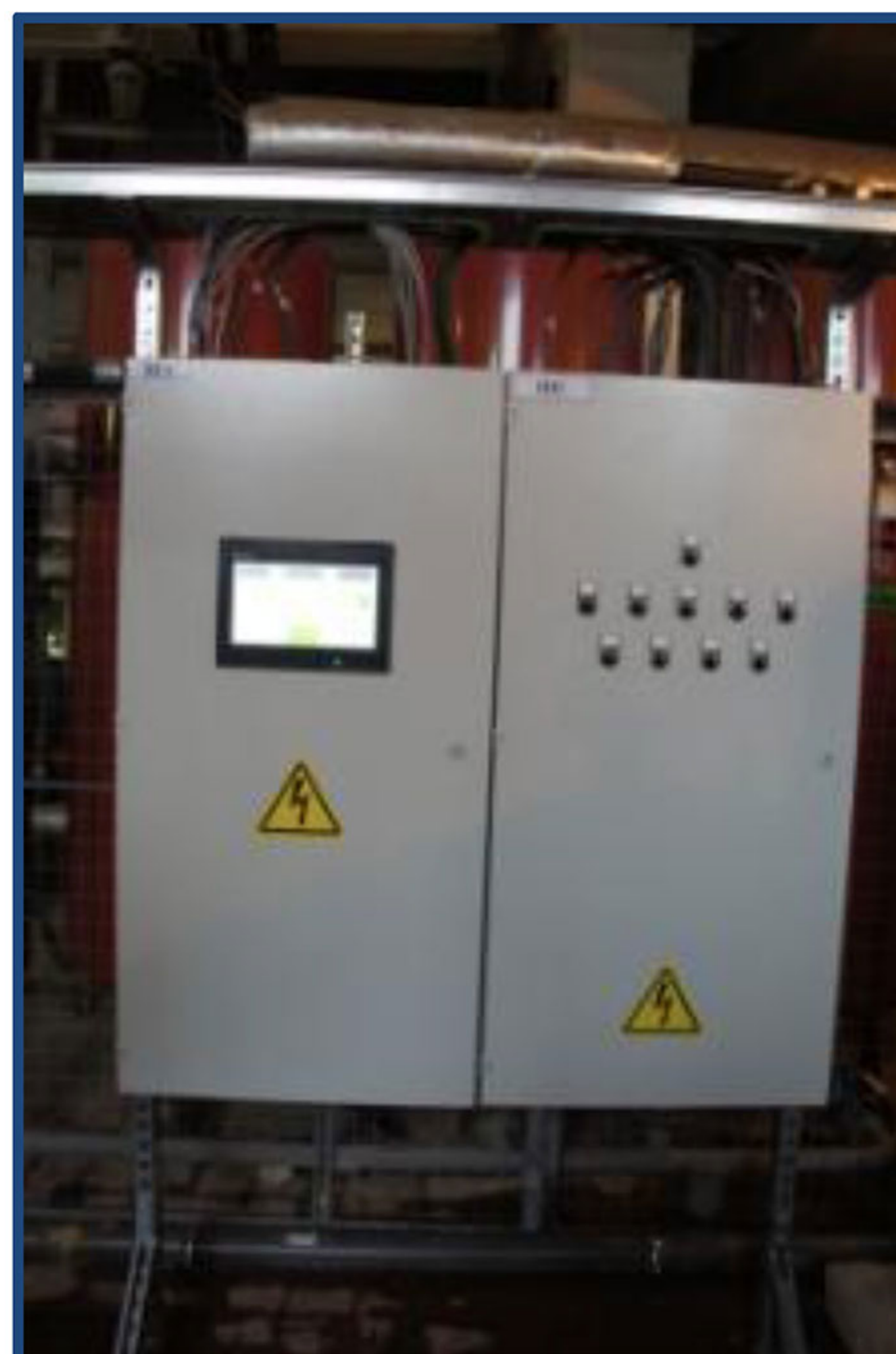
Панель оператора DELTA DOP-B для визуализации процессов и отображения параметров работы ПЛК
