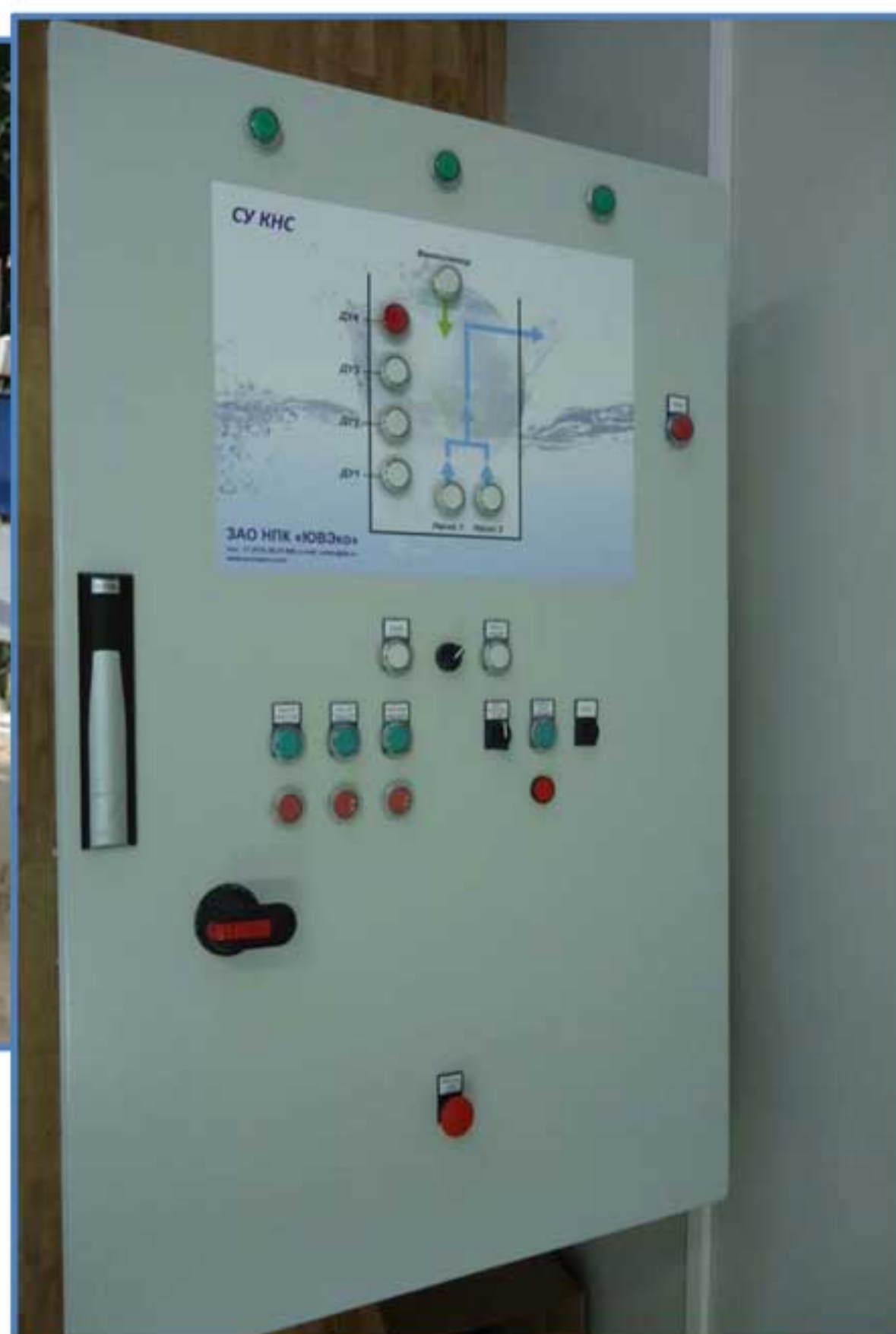
Шкаф управления КНС с УПП AuCom серии CSXi и ПЛК DVP-SS2
