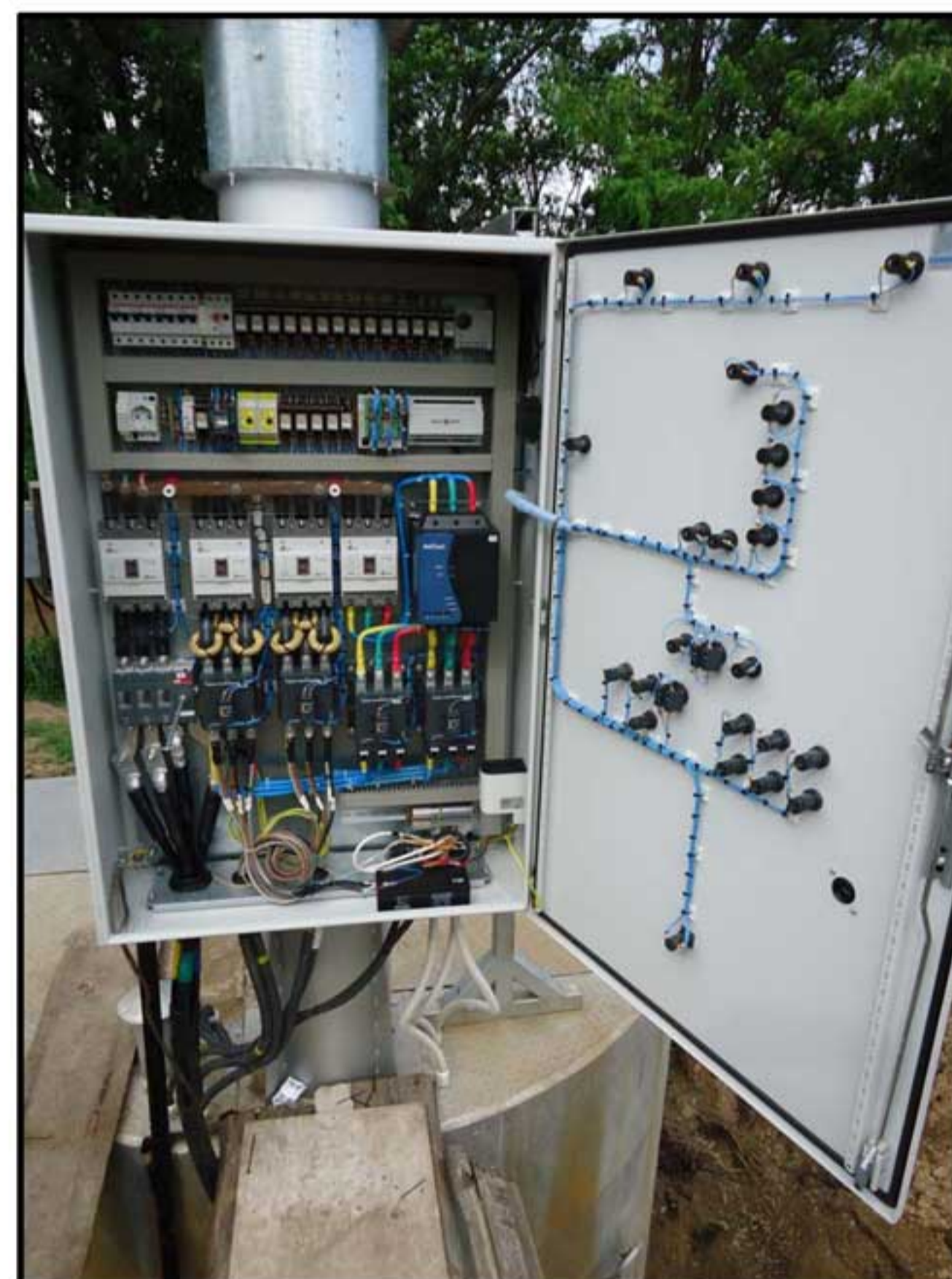
Шкаф управления КНС с УПП AuCom серии CSXi и ПЛК DVP-SS2
